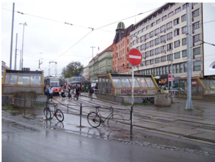
Obrázek č. 3 30 : Chybějící stojany na Hlavním nádraží
